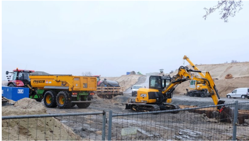
Derzeit wird an Brücken und Auffahrten wie hier bei Buxtehude gebaut.
