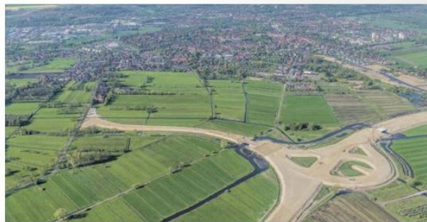
Die Buxtehuder Anschlussstelle ist im Bau, der Anschluss an die Stadt dagegen noch nicht geplant Foto: Der Luftbildfotograf/Martin Elsen
