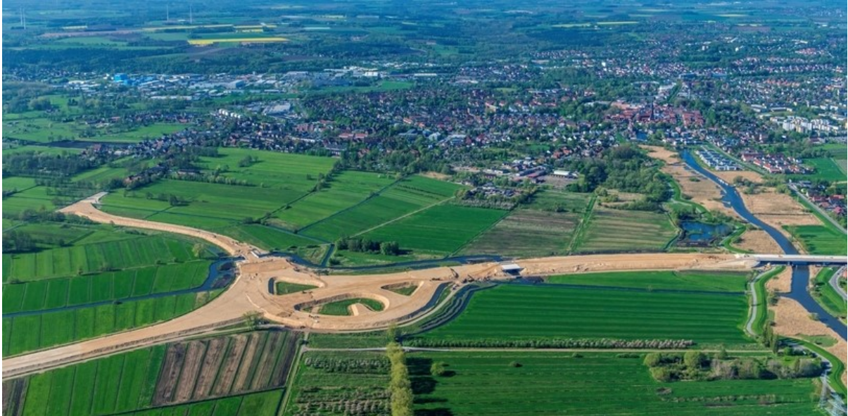
Die Autobahnanschlussstelle Buxtehude-Mitte ist bereits gut zu erkennen. Foto: Elsen
