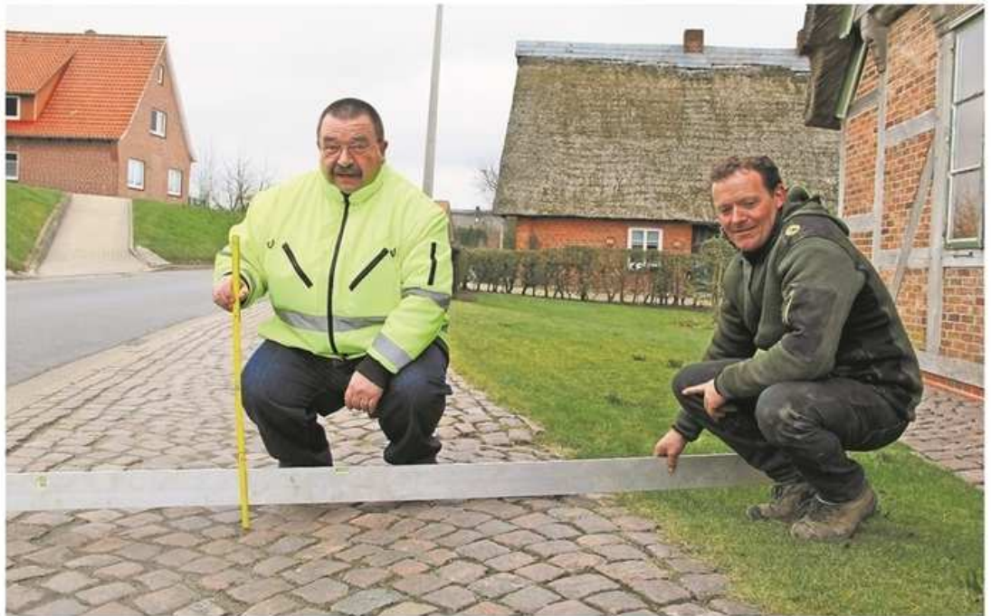
Vor dem Betrieb von Andreas Heitmann (rechts) brettern immer wieder schwere Lkw und Linienbusse über den Gehweg, um an der Engstelle nicht halten zu müssen. Bürgermeister Joachim Streckwaldt misst nach: Die Spurrinne ist sechs Zentimeter tief.
