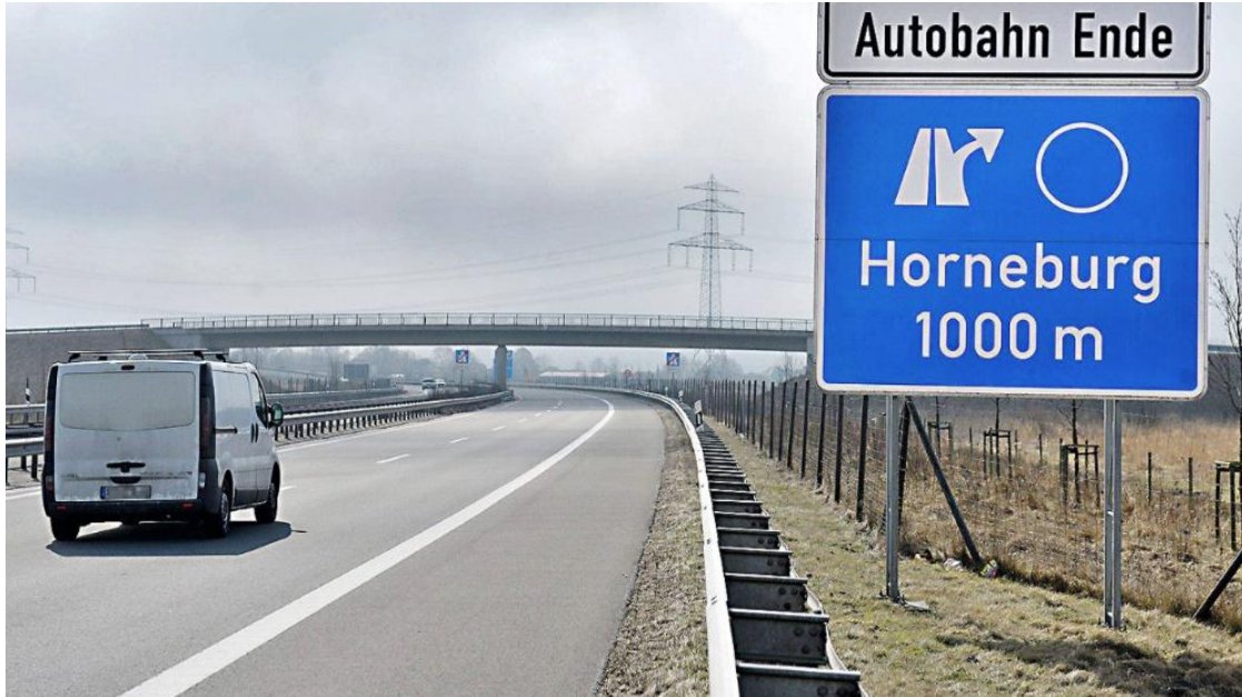
Die A 26 – hier die Ausfahrt Horneburg – ist auf niedersächsischer Seite schon teilweise fertig und befahrbar Foto: dpa
