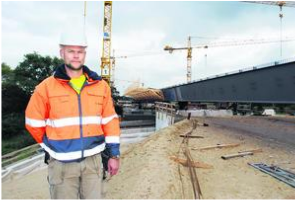
Projektleiter Dennis Babig (Zwickauer Sonderstahlbau) vor dem riesigen, stählernen Haupttragwerk, das Stück für Stück über die Este geschoben wird (Foto: bc)
