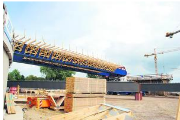
Auf die Tragwerke werden später Stahlbeton-Platten gelegt
