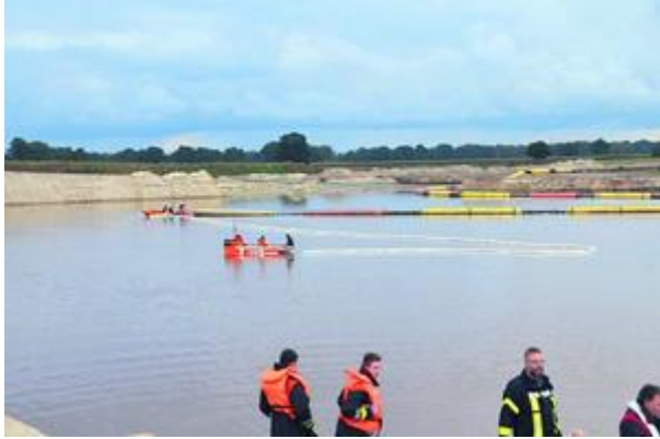
Eine Ölsperre rund um den untergegangenen Bagger soll verhindern, dass Diesel ans Ufer gelangt
