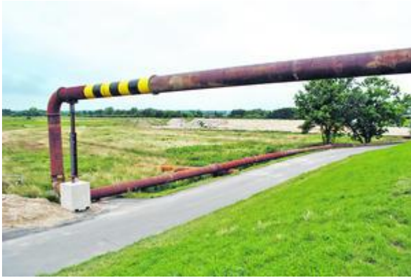
Die Rohrbrücke über die Moorender Straße wird nach einigen Wochen wieder abgebaut (Foto: bc)
