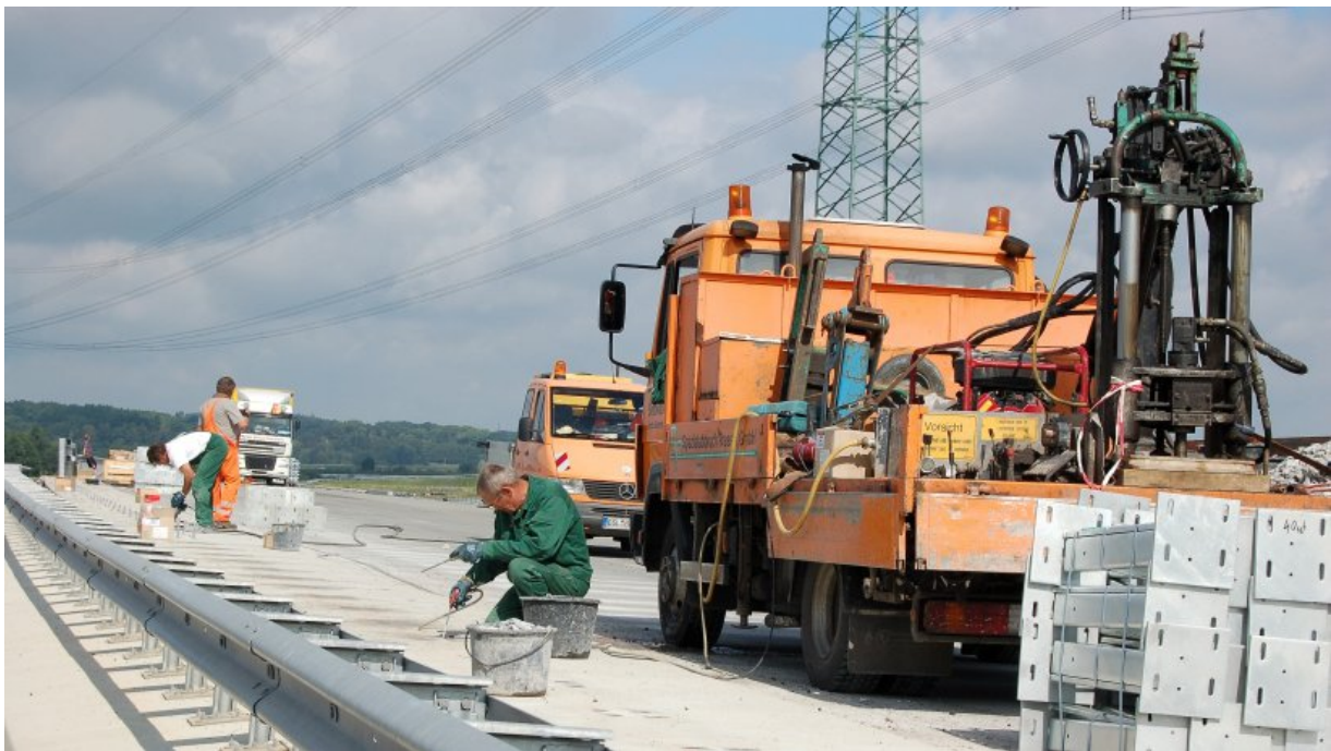
Baustelle A 26 – 1. Bauabschnitt zwischen Stade und Horneburg steht kurz vor der Fertigstellung
